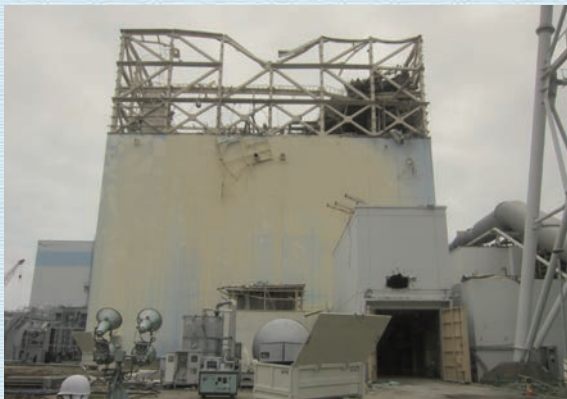
福島第一原子力発電所1号機(平成24年6月18日 福島県災害対策本部撮影)
