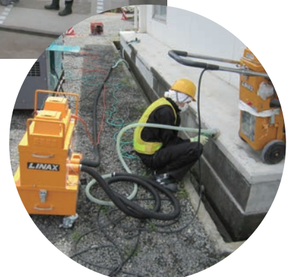
建物の表面の除染を行っています
