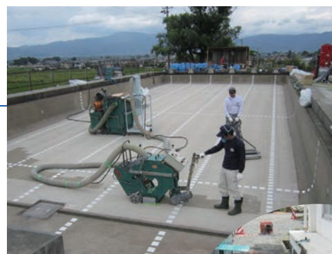
プールの底の除染を行っています
